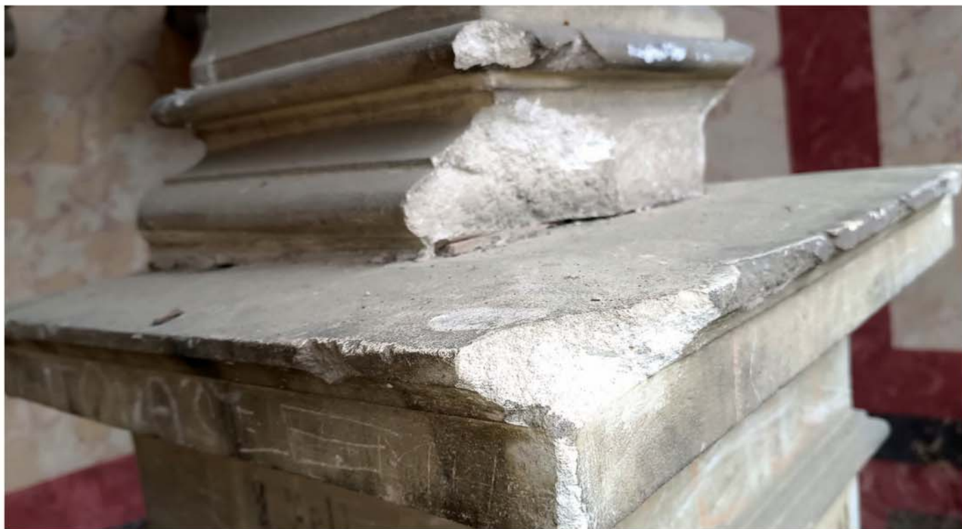
Rozsáhlá poškození architektury podstavce.
