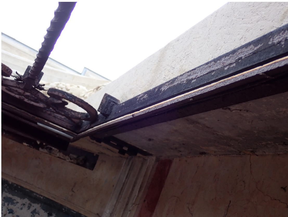
Zasklívací profil se zbytkem tmelu, kde byla osazena skleněná výplň
