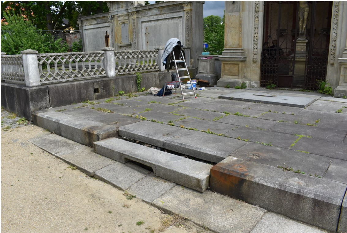
Obr. 5 Dlažba kolem hrobky s uvolněným stupněm
