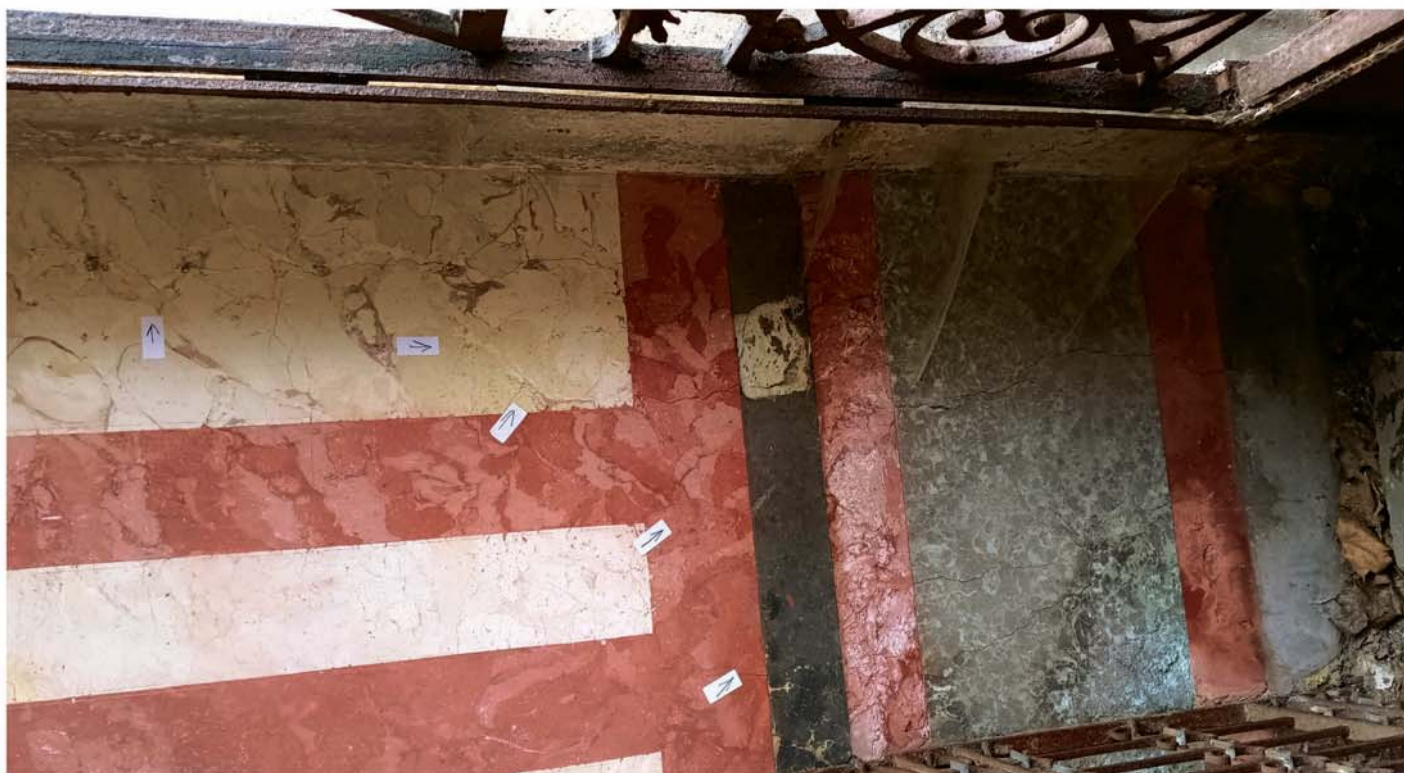
Pohled na část stěny na pravé straně s označením defektů a míst s kavernami.
