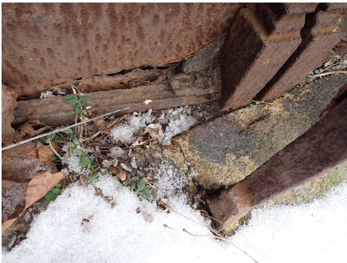
Detail korozního napadení spodní části hlavní mříže
