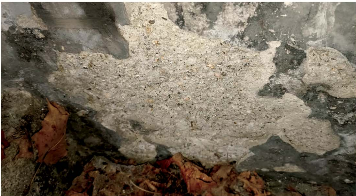
Stav voskové výmalby nad schodištěm v jeho spodní části u vstupu do krypty. Barevná vrstva je místy opadaná, silně se zde projevuje vlhkost.
