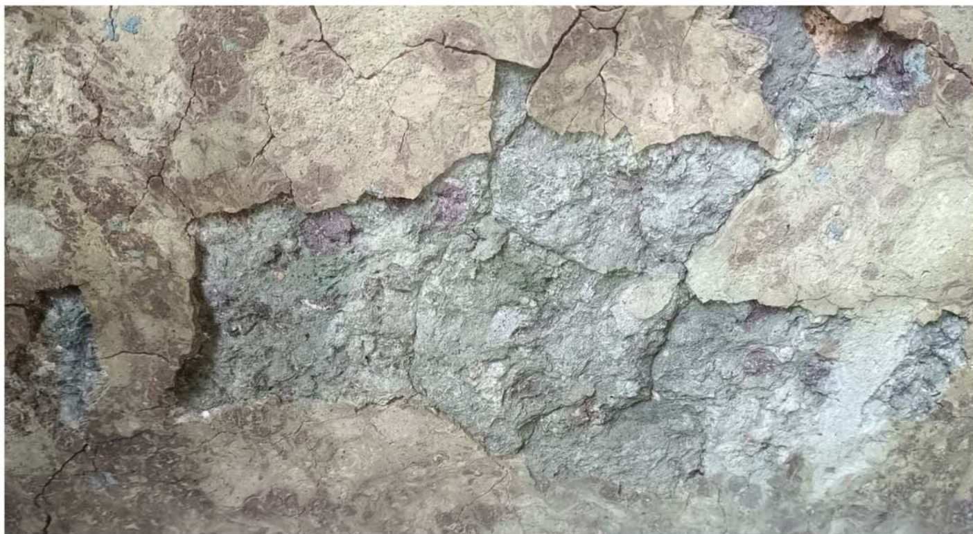
Ukázka vydroleného stucco lustra. Barevná retuš přímo na jádrový podklad.
