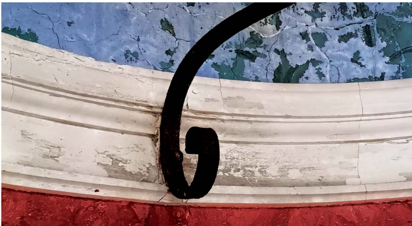
Síť prasklin v konše nad římsou a praskliny v profilované sádrové římse.
