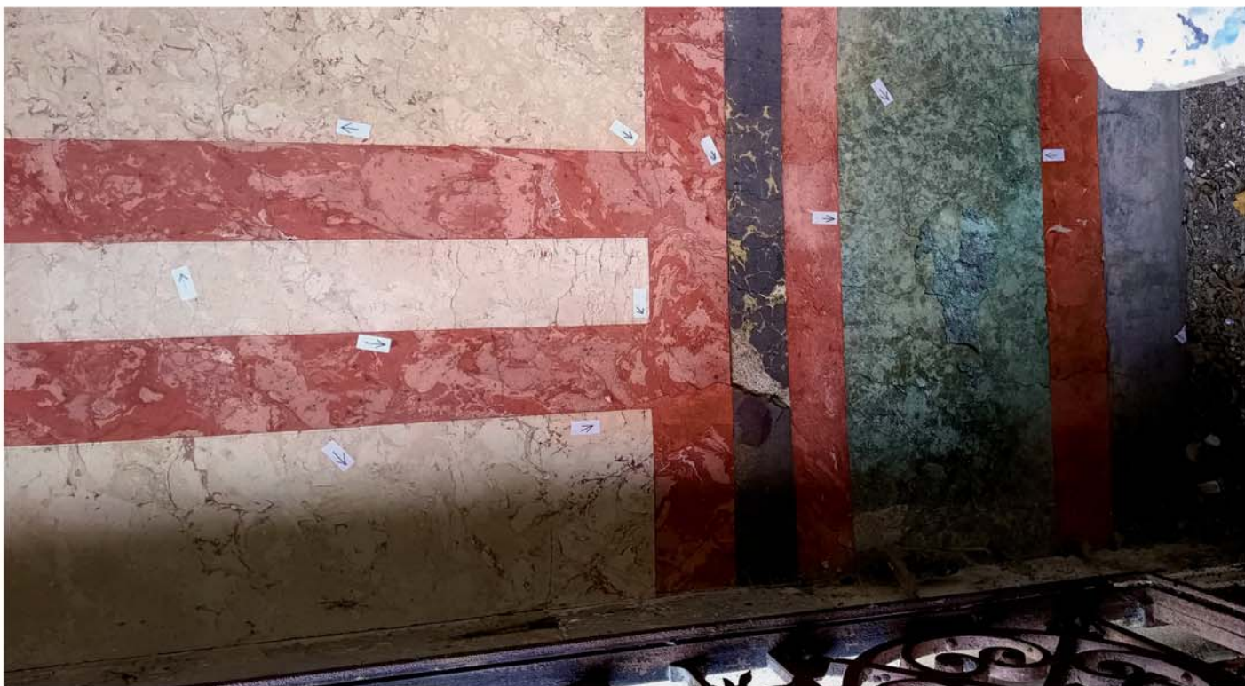
Pohled na část stěny na levé straně s označením defektů a míst s kavernami.
