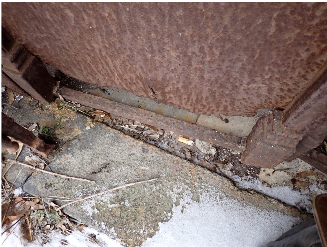
Korozní napadení spodní části hlavní mříže
