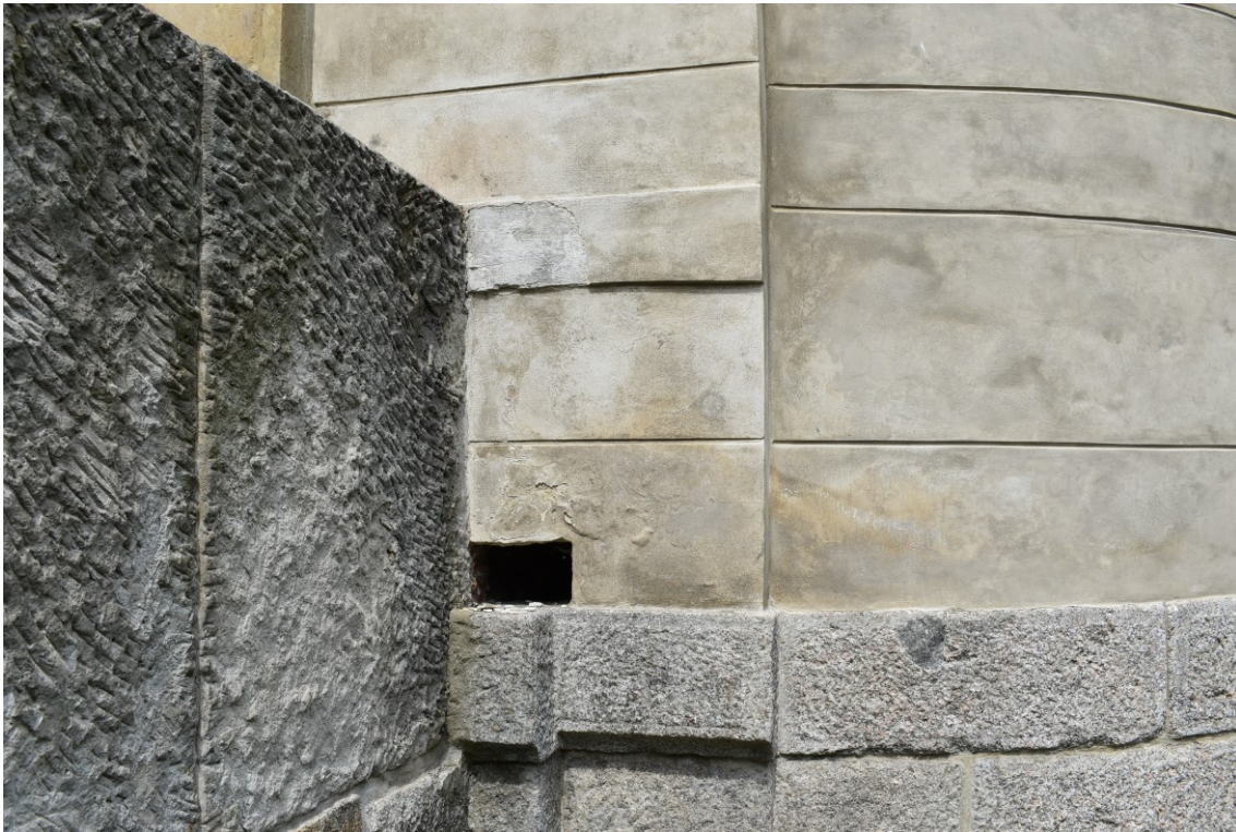
Obr. 7 Lokální poškození omítky
