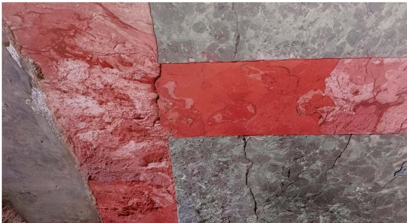
Vydrolené stucco lustro. Barevná retuš na jádrový podklad.
