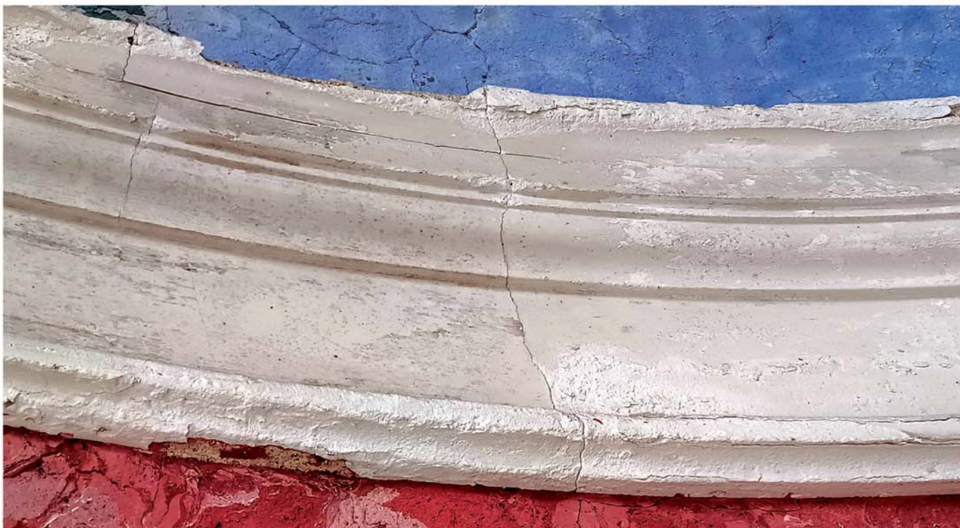
Poškození sádrové římsy. Vrchní část je olámaná a odrolená, patrná je jedna z prasklin profilu.
