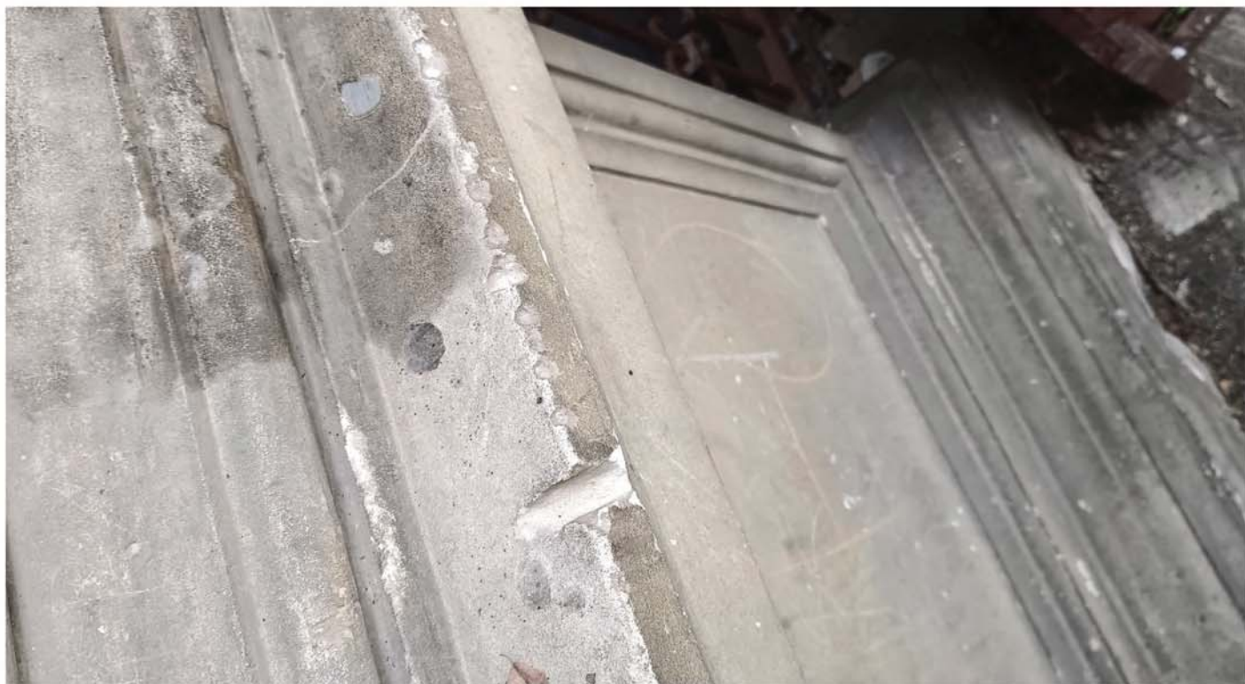
Drobnější poškození podstavce.
