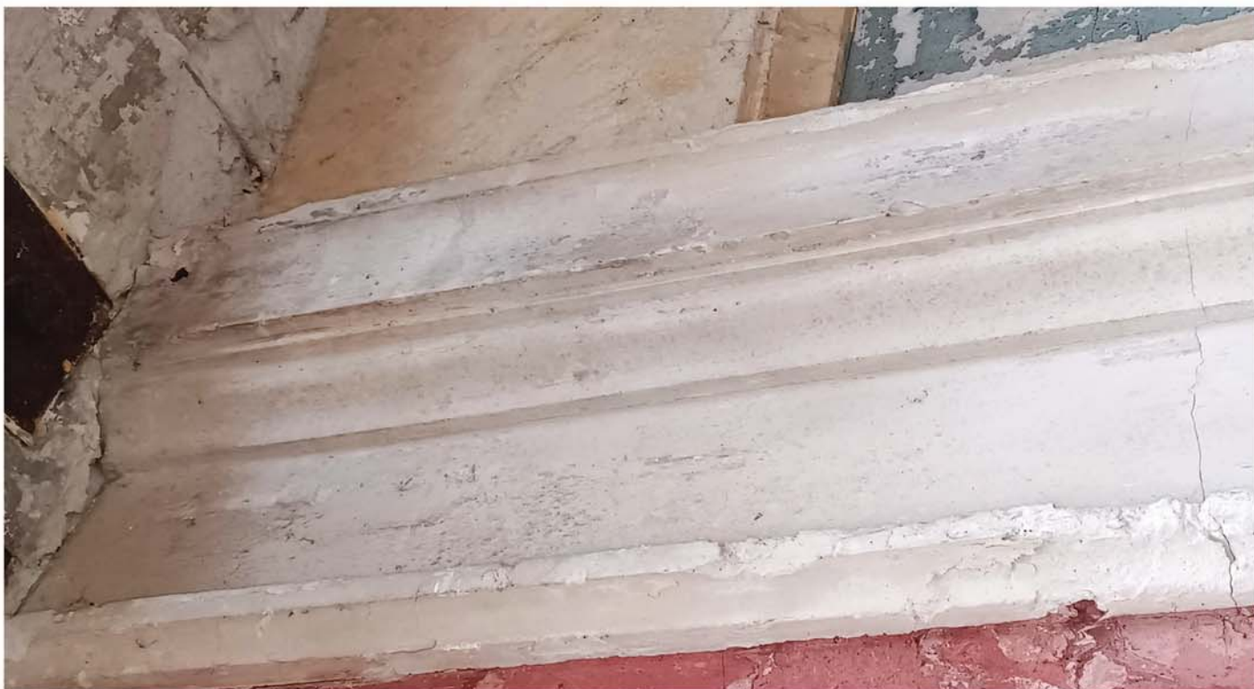
Stav štukové římsy. Hrany jsou otlučené a rozdrobené.
