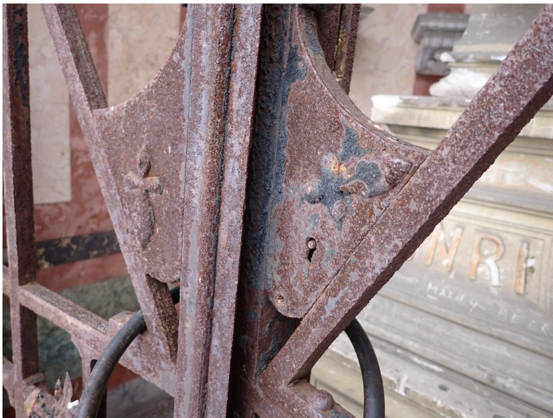
Detail nefunkčního zámku mříže
