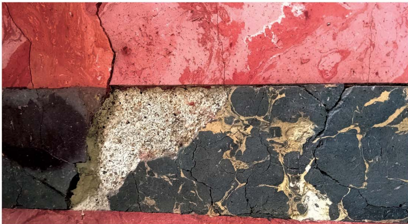
Rozpraskané a opadané stucco lustro.
