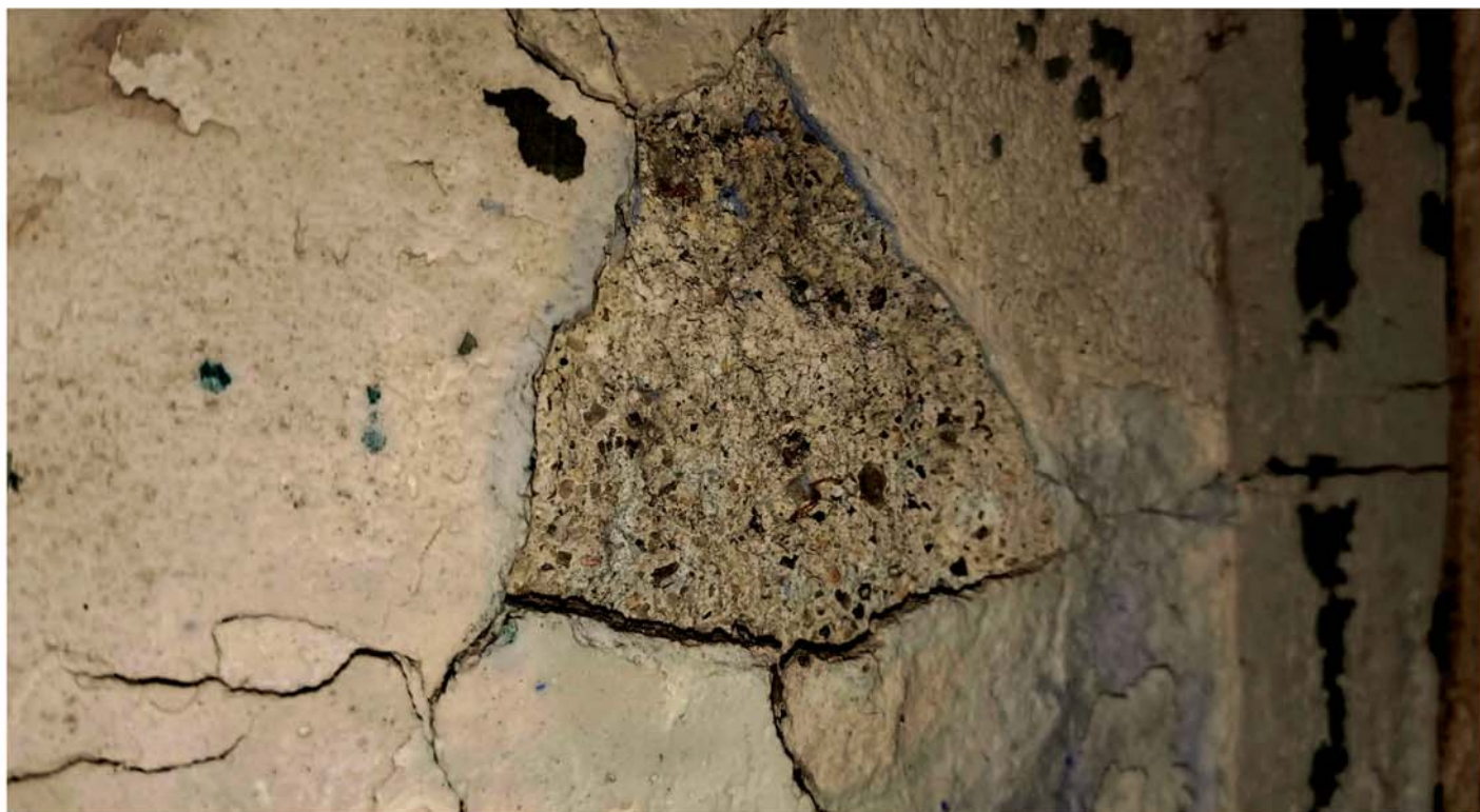
Detail odpadlého podkladu malby na jádrovou omítku.
