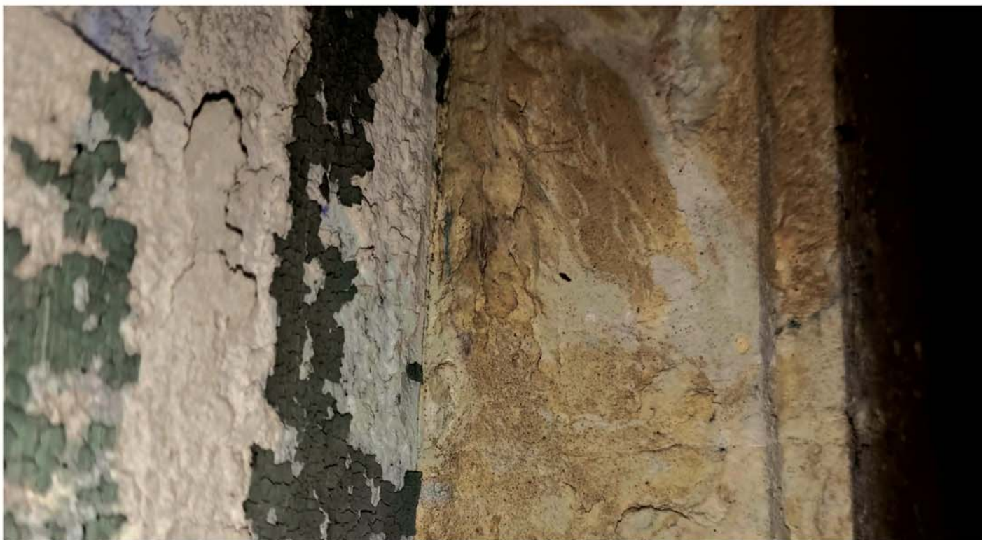
Detail zkrakelované barevné vrstvy v pásu vstupního oblouku. Zvětralá a naboptnlá je zde i část profilu stucco lustra.
