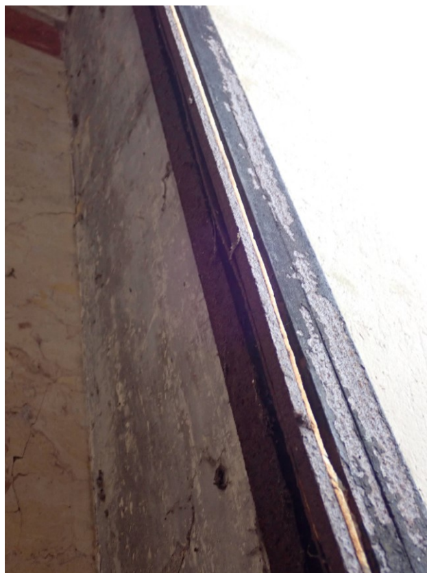
Zasklívací profil s tmelem
