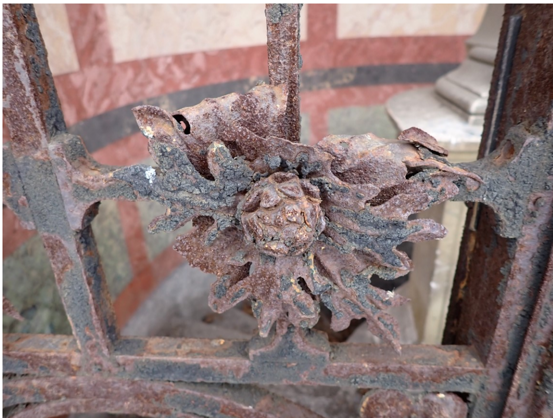
Detail poškození zdobného květu ze středové části hlavní mříže
