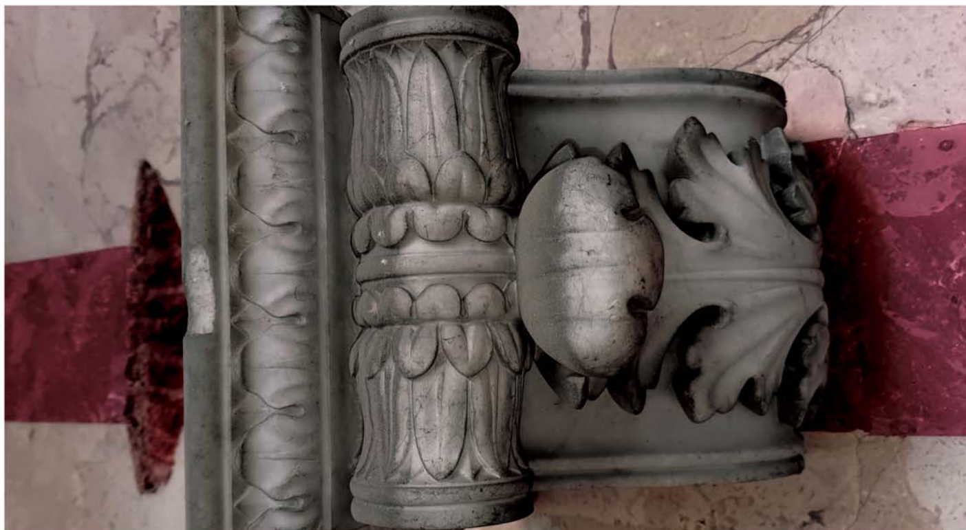
Poškození profilu mramorové konzole - malý úlomek v horní části. Možná souvislost se zásahem do stucco lustra nad ní.
