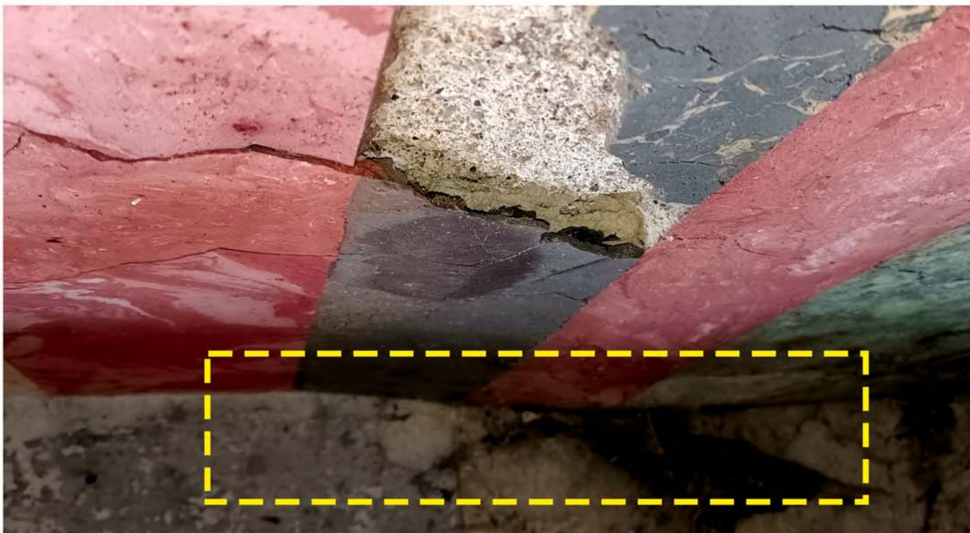
Místo s havarijním poškozením stucco lustra. V místě označení je patrná vlna převýšení způsobená oddělením štukové vrstvy od podkladu.
