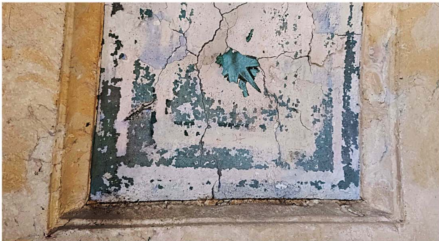
Pohledově levá strana vstupního oblouku nad římsou. Současný stav spodní části pásu nesoucího původní dekorativní malbu. Barevná vrstva je zkrakelovaná, zprášená a opadaná, podklad malby je rozpraskán.
