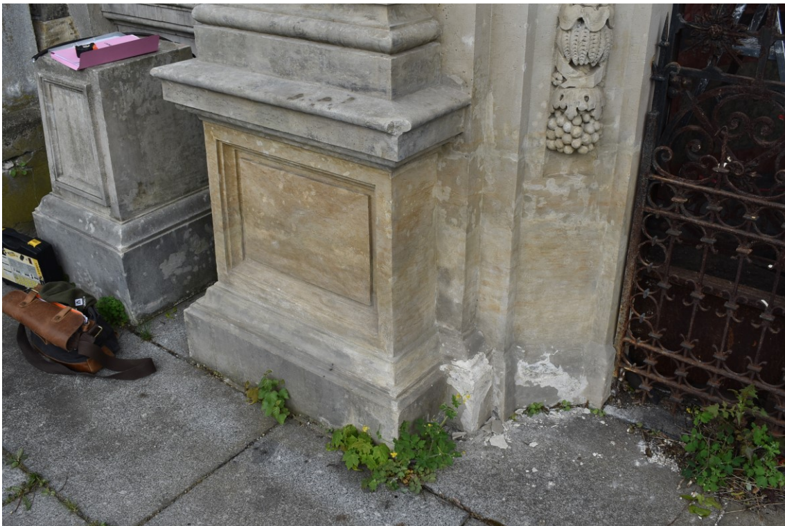
Obr. 8 Lokální poškození profilace
