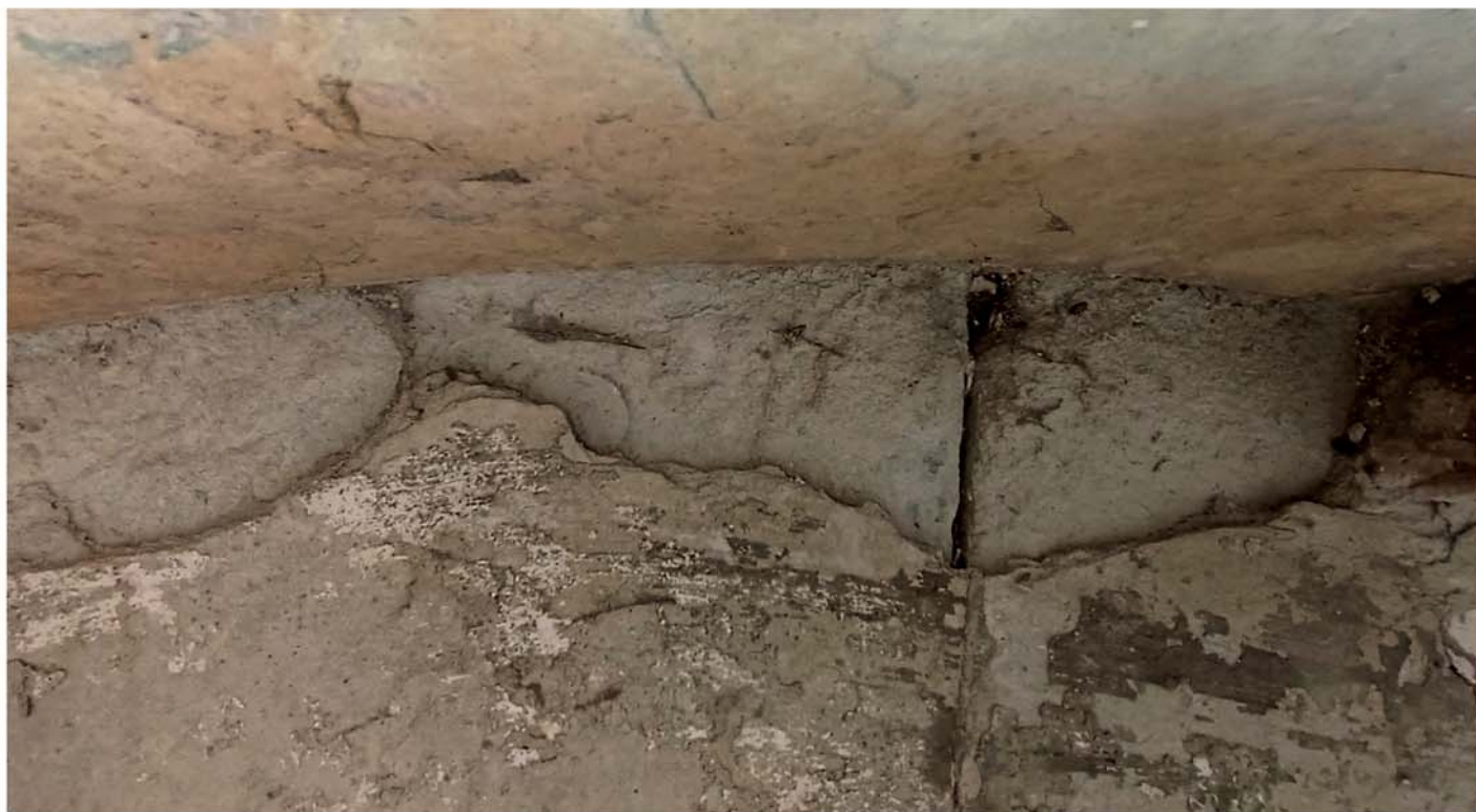
Rubová strana čelní stěny objektu. omítky jsou nesoudržné.
