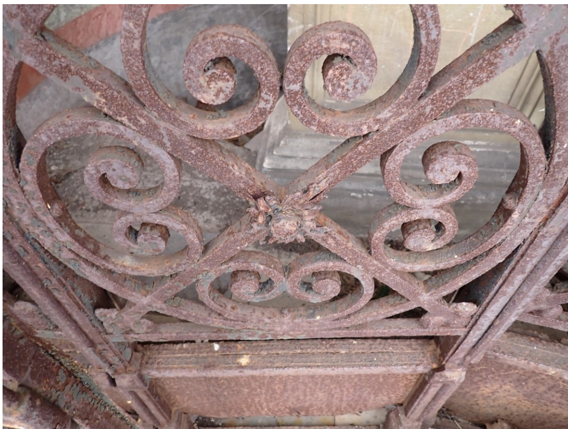
Detail poškození středového květu na spodní části mříže
