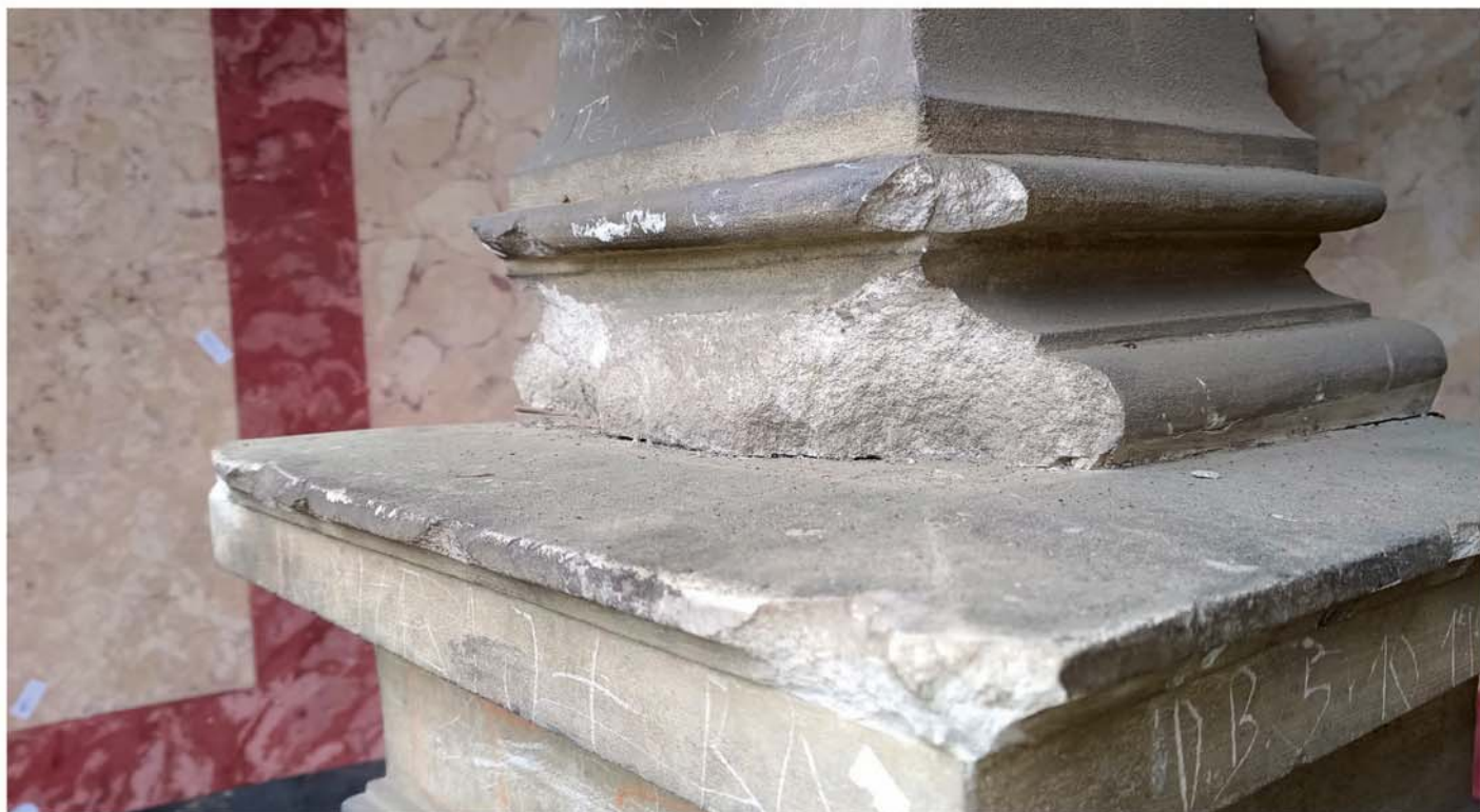
Rozsáhlá poškození architektury podstavce.
